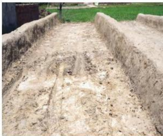
Kaccha Bunker Silo
